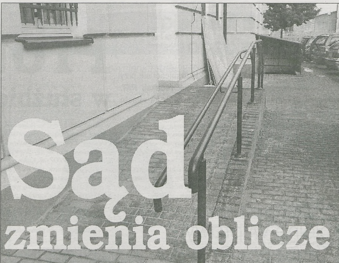
Niepełnosprawni mają teraz ułatwiony wjazd do sądu
