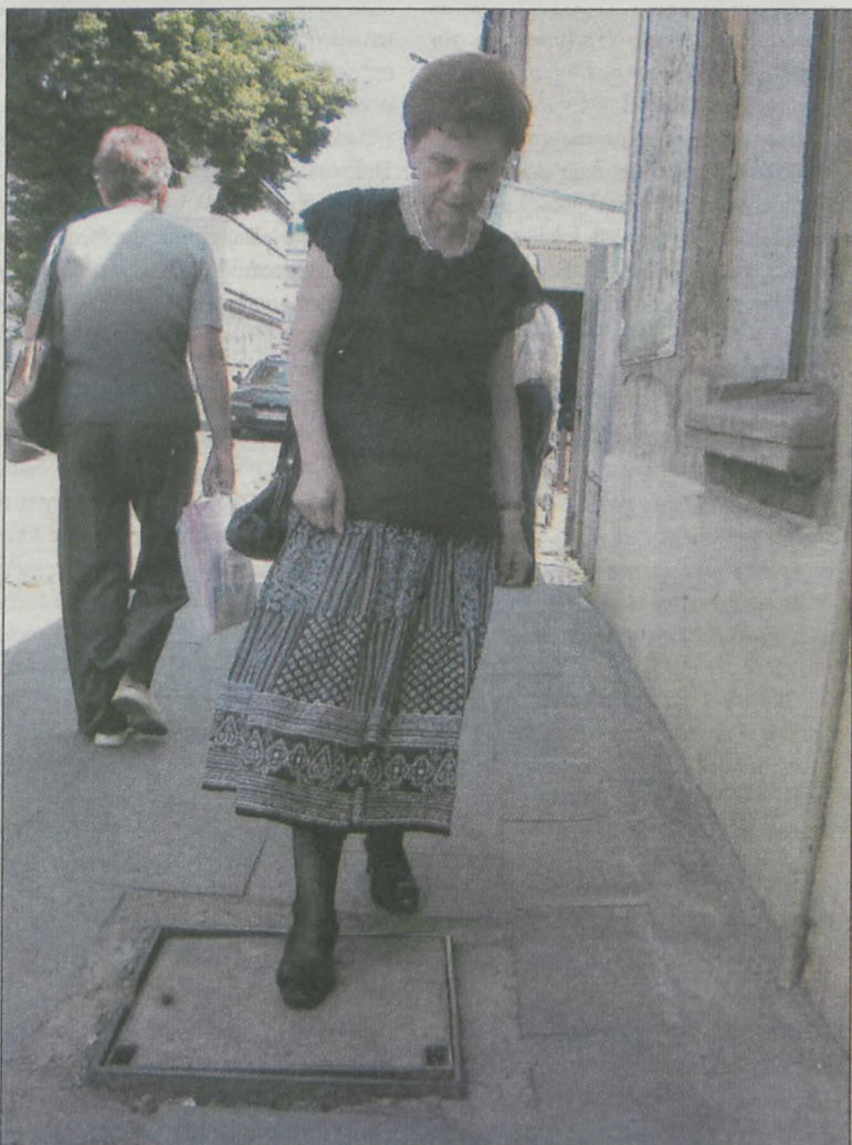
Na chyboliwej pokrywie studzienki można było stracić równowagę i upaść
