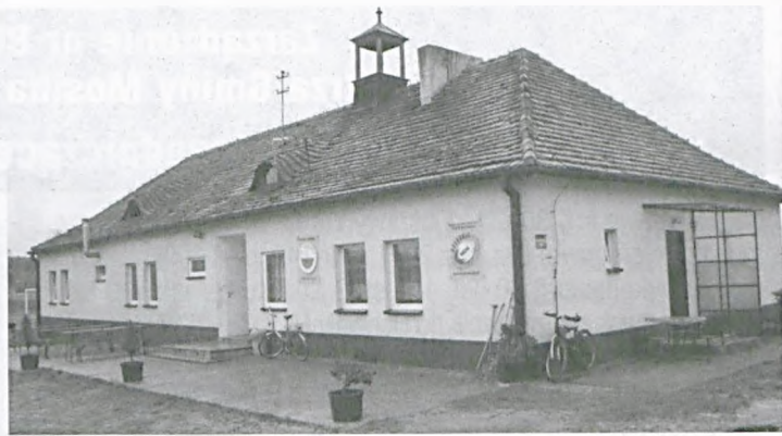
Budynek przed remontem
