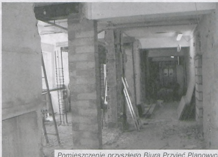
Pomieszczenie przyszłego Biura Przyjęć Planowych
