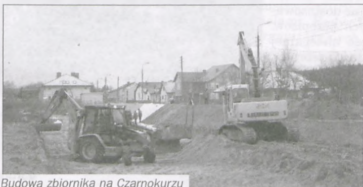
Budowa zbiornika na Czarnokurzu
