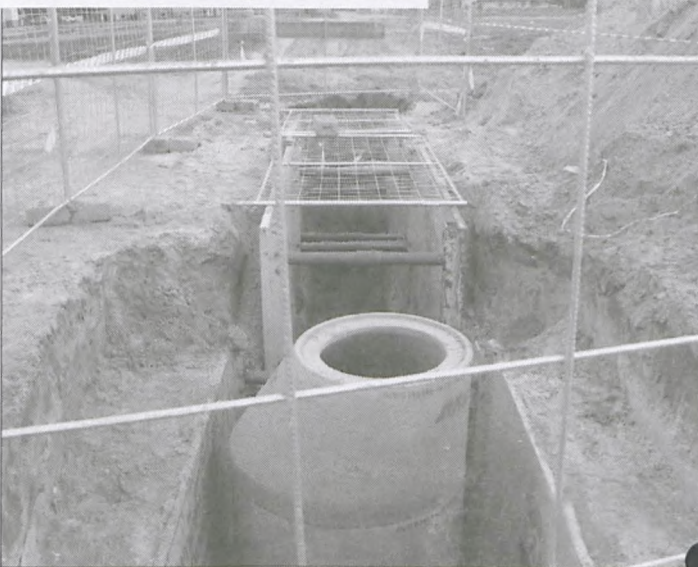
Budowa kanalizacji – ul. Polna
