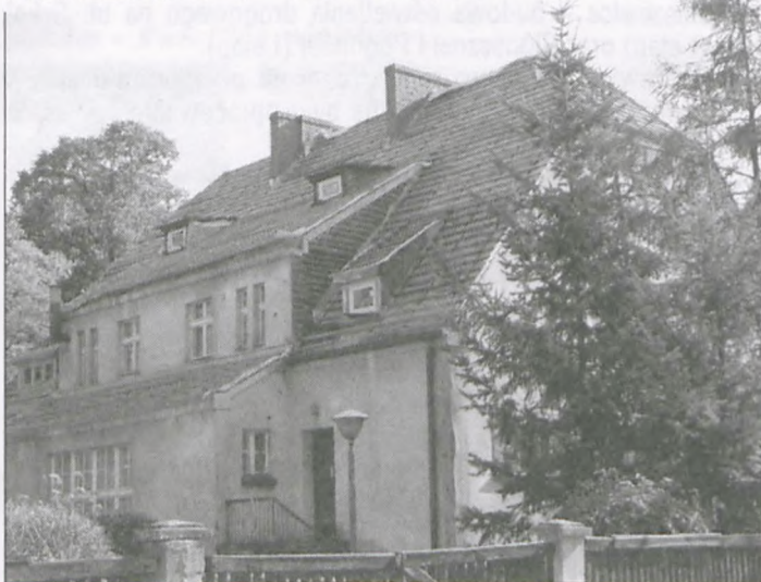
Przedszkole nr 4 – remont dachu
