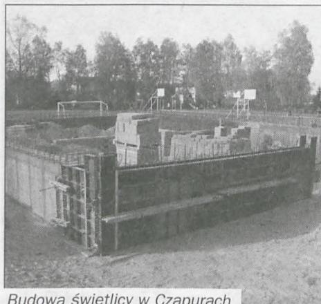
Budowa Świetlicy w Czapurach
