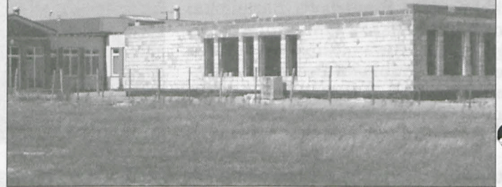
Budowa nowego segmentu szkoły podstawowej Mosina – Krosno
