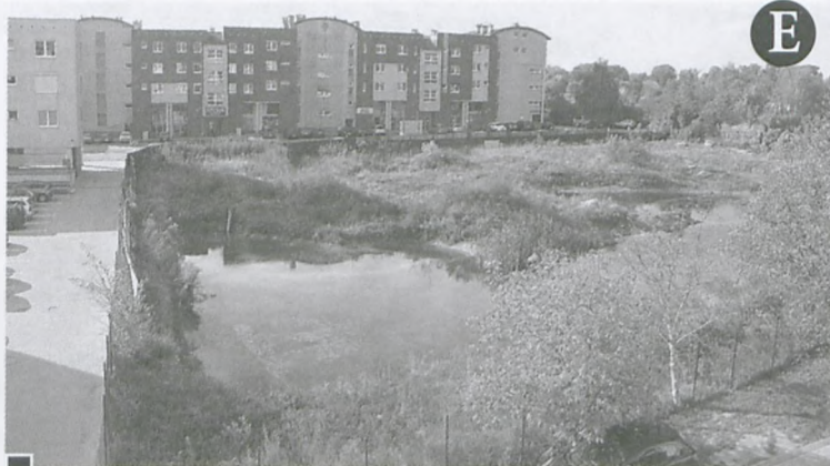
Teren przy ul. Wschodniej, gdzie przed kilku laty podjęto prace przygotowawcze pod budowę 3-skrzydłowego, 5-kondygnacyjnego bloku (na mapce oznaczony NCS naprzeciw poczty). Wykonawca zrobił częściowy wykop pod fundamenty i przepadł. Od strony ul. Wschodniej wciąż widnieje tablica z projektem budynku. Właściciel gruntu zapewnia bowiem, że nie odstąpił od inwestycji. Dziś wykop z wodą gruntową to regularny staw obrosnięty bazią będący schronieniem m.in. dla żab, których głośnie kumkanie rozlega się po okolicy. fot. Hanna Siatka
