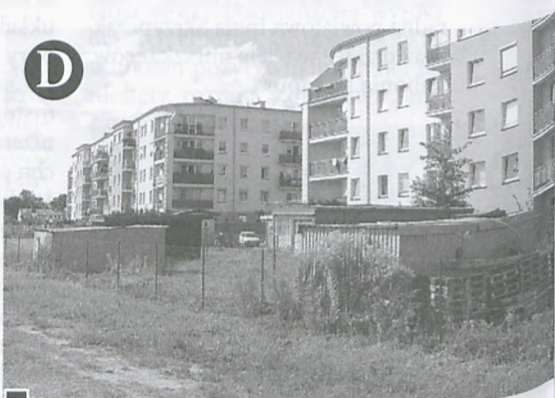
Opłotowany, zarośnięty, nieestetyczny obszar pomiędzy blokami 20, 25 A i B, 25 C i D oraz ul. Konarzewskiego zgodnie z „Miejscowym planem zagospodarowania przestrzennego – Luboń Centrum” powinien być terenem urządzonej, niskiej, ogólnodostępnej zieleni. Od czasu wybudowania osiedla (2007 r.) stoją tu szopki, wiaty i resztki sprzętu (na mapce – w części dolnej) fot. Hanna Siatka
