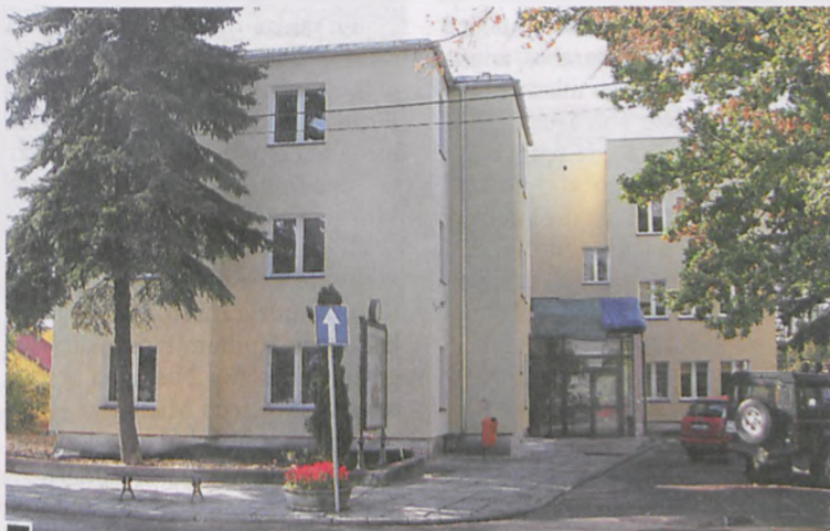
Budynek Urzędu Miasta po ociepleniu. Do wykonania pozostała jeszcze m.in. modernizacja wejścia do gmachu fot. Hanna Siatka
