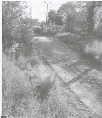
Pas dawnej bocznicy kolejowej Zakładów Ziemniaczanych, pod którym biegnie tunel dla pieszych oddzielający tereny spółdzielni Mieszkaniowej „Spójnia” – dziś droga dla ciężkich samochodów Pajo fot. Piotr P. Ruszkowski
