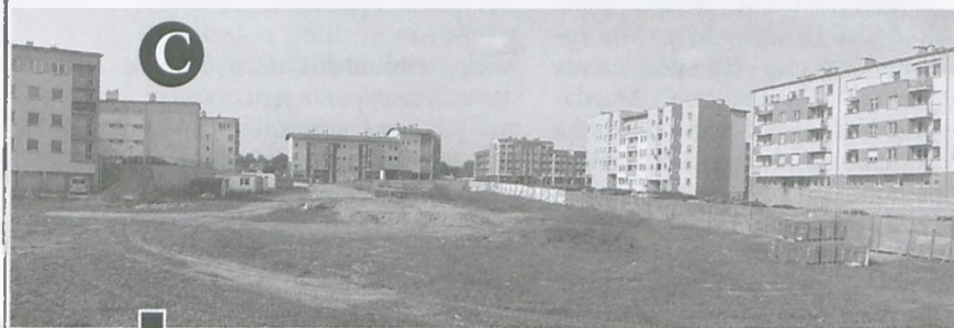
Widoczny od strony wschodniej, świeżo ogrodzony plac budowy planowanego osiedla „Wschodnia” firmy IMMO-INVEST, na którym we wrześniu ruszyły wspomniane prace przy realizacji pierwszego z dwóch planowanych bloków fot. Hanna Siatka
