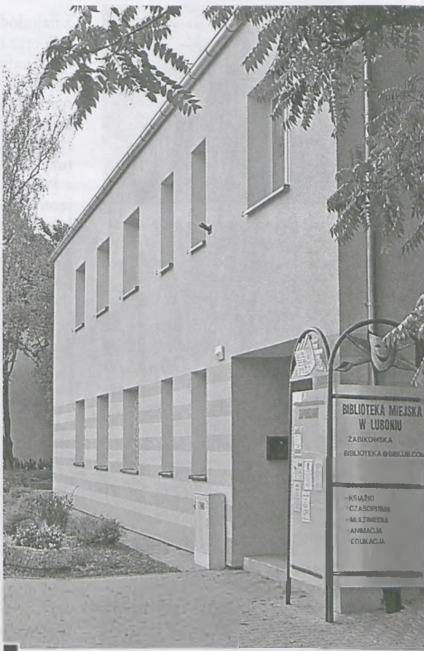
Nowa elewacja Biblioteki Miejskiej w Lublinie z odnowioną tablicą fot. Mariusz Marszałkiewicz
