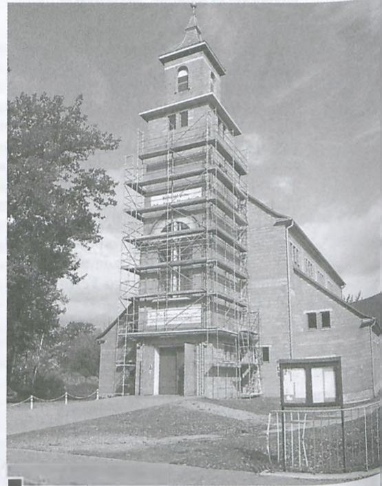
Przygotowania do tynkowania wieży – rozstawiono rusztowanie fot. Grzegorz Wiśniewski
