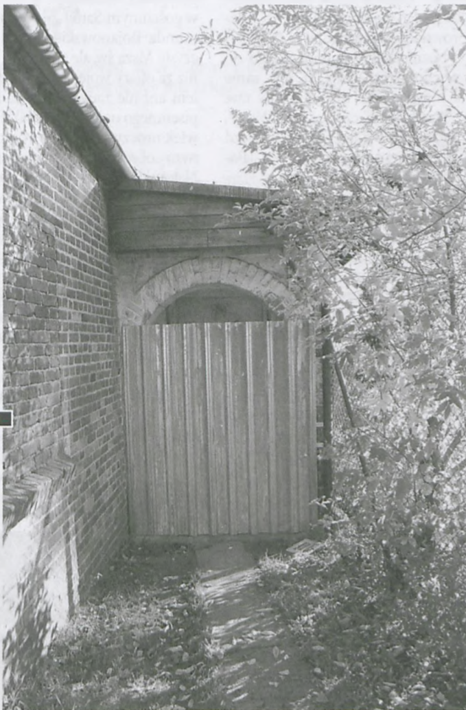
Zabezpieczone blachą wejście do tunelu łączącego dawne domy pracowników na terenie Zakładów Ziemniaczanych z ul. Armii Poznań (dziś wydzielona działka oddana spółdzielni „Spójnia”) fot. Piotr P. Ruszkowski
