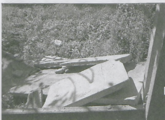
Zniszczony płot ROD Bratek fot. Jan Błaszczak
