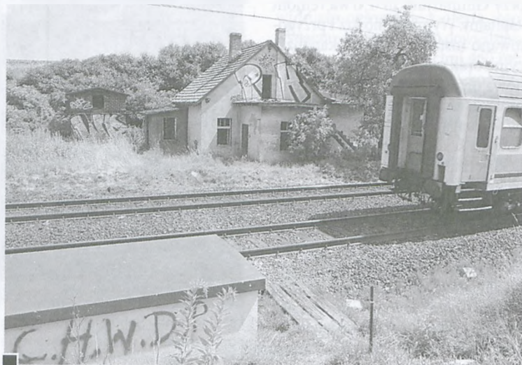
Dom należący do PKP pomiędzy torami w pobliżu ul. Krętej jest – regularną meliną. Jak się okazuje, budynek ten nigdy nie miał adresu fot. Piotr P. Ruszkowski
