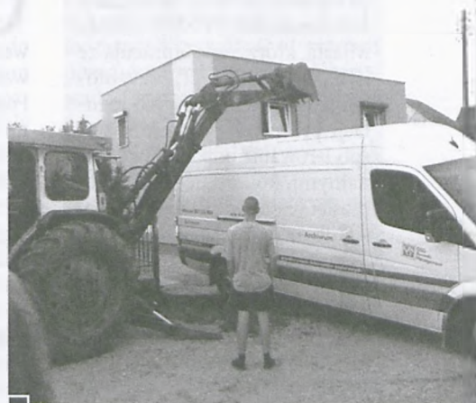
Próba wjazdu na posesję (nieudana z powodu zbyt wysokiego krawężnika) skończyła się wezwaniem ciężkiego sprzętu i przestawieniem pojazdu
