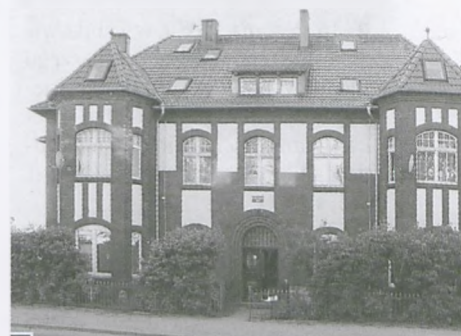
Dom przy ul. Armii Poznań 64, gdzie na I piętrze do 1939 r. mieszkała rodzina Antoniego Marcinkowskiego. W związku z poszerzeniem ul. Armii Poznań ten uznany za najpiękniejszy dom mieszkalny w Luboniu zostanie prawdopodobnie rozebrany fot. Piotr P. Ruszkowski
