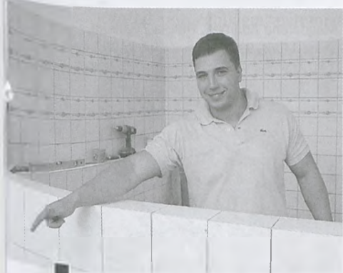
Sebastian Guzik – szef kuchni LOSiR – w remontowanej części gastronomicznej Gimnazjum nr 1, w sektorze przygotowania wstępnej warzyw i jaj, pokazuje wydzielony specjalną ścianką sektor, gdzie przed obróbką termiczną przygotowywane będą mięsa fot. Piotr P. Ruszkowski
