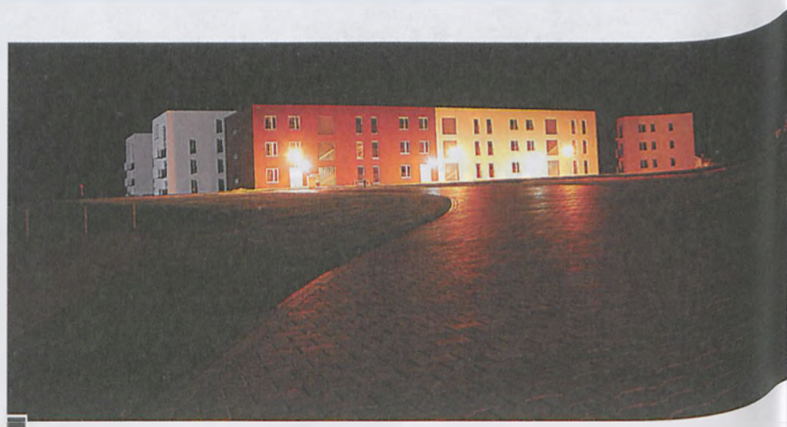
Od strony ul. 3 Maja przy mostku Strumienia Junikowskiego, przez plac Medalistów, zakolami prowadzi pozbukowy wjazd na ul. Jachtową, gdzie zasiedlane są pierwsze bloki osiedla Warta Park fot. Piotr P. Ruszkowski
