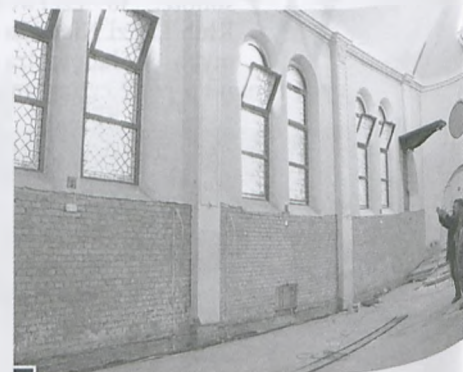
Ściana zachodnia z odkutym tynkiem do poziomu okien fot. Hanna Siatka
