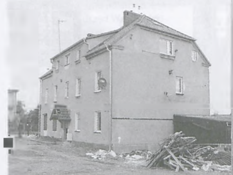
Budynek wielorodzinny przy ul. Łącznej 6, przy którym trwa remont fot. Piotr P. Ruszkowski
