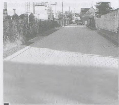
Ul. ks. Nogali po budowie fot. Paweł Wolniewicz
