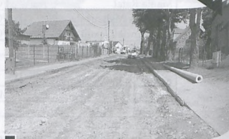
Ul. Kręta – remontowany fragment od strony Wir w kierunku ul. Sobieskiego. Zdjęto starą nawierzchnię. Droga przygotowana jest do położenia nowej. Wymienione zostaną też chodniki oraz słupy energetyczne fot. Piotr P. Ruszkowski
