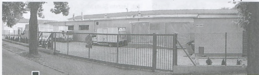
Kompleks nowoczesnej Pralni Luboń przy ul. Szkolnej 1b, składający się z hali, punktów: przyjęć i wydawania prania, zaplecza biurowego oraz placu dla samochodów dostawczych fot. Hanna Siatka
