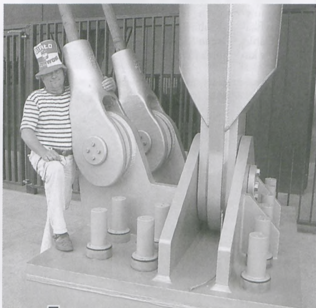
Adam Ruszkowski przy jednym z potężnych mocowań konstrukcji linowej Stadionu Narodowego w Warszawie
