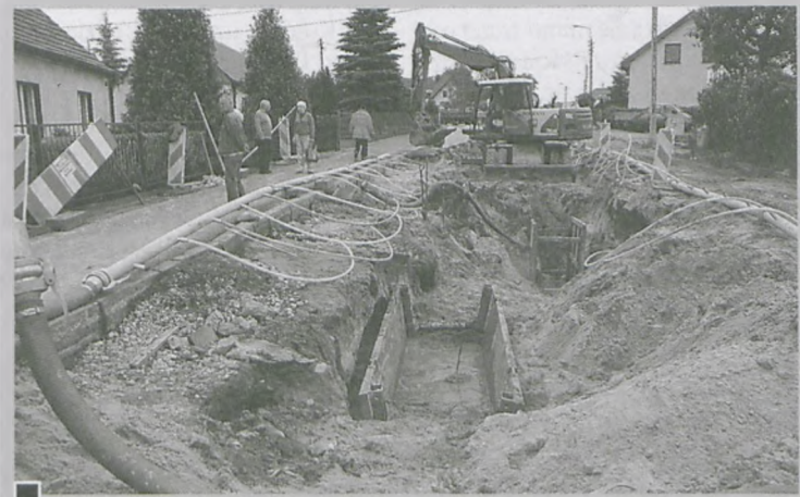
Przy okazji przebudowy ul. Krętej kładzie się kanalizację sanitarną fi 500, która w przyszłości (za ok. 2 lata) zostanie włączona do budowanej w ramach wielkiego projektu kolektora w przyszłej ul. Dworcowej fot. Piotr P. Ruszkowski
