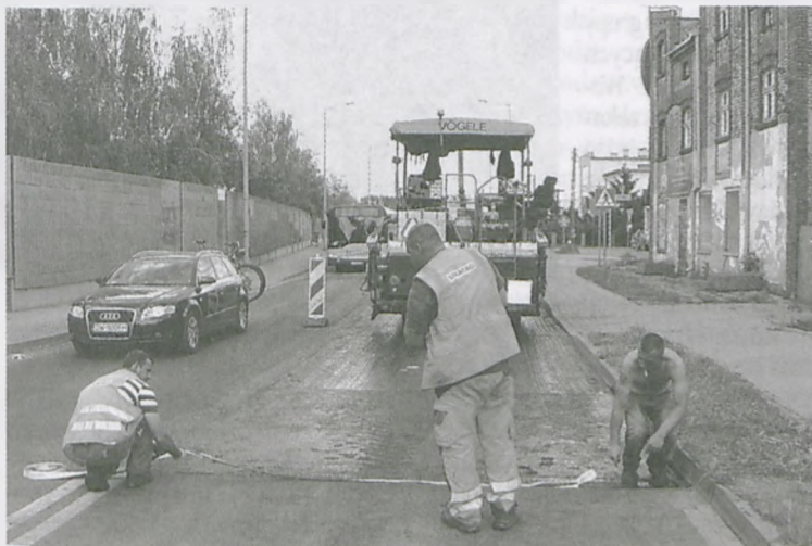
Pracownicy firmy STRABAG na końcu remontowanego odcinka jezdni przy ul. Armii Poznań rozwijają taśmę. Pozostało tylko wylanie nowego dywanika asfaltu, posypanie go drobnym grysem i uwalcowanie fot. Paweł Wolniewicz
