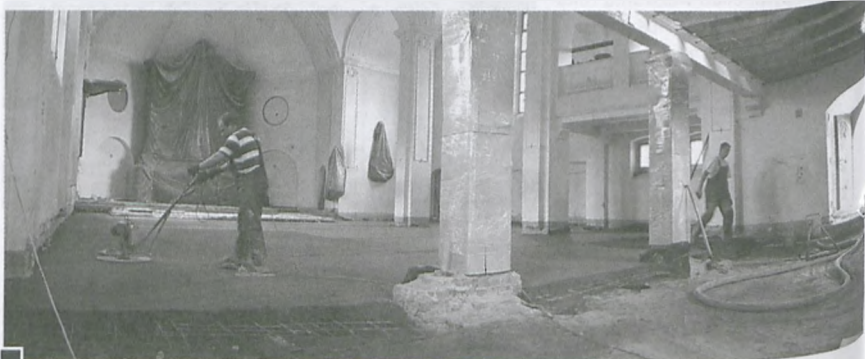
Etap zacierania betonu spodniej warstwy posadzki w kościele św. Barbary – 23 maja 2012 r. fot. Hanna Siatka
