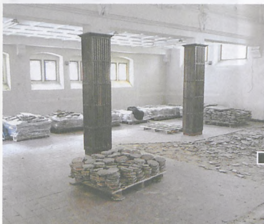
■ Zdejmowanie sześciokątnych i kwadratowych płytek klinkierowych z posadzki. Część z nich zostanie zachowana fot. Rafał Wojtyniak
