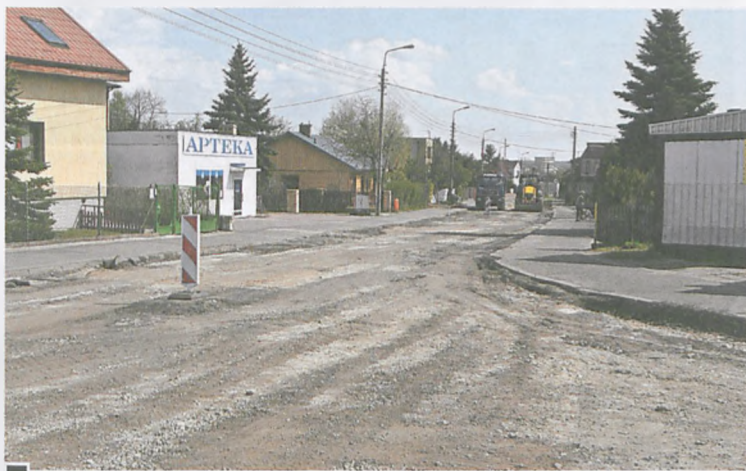
Stan robót na ostatnią dekadę kwietnia fot. Tomasz Chojnacki
