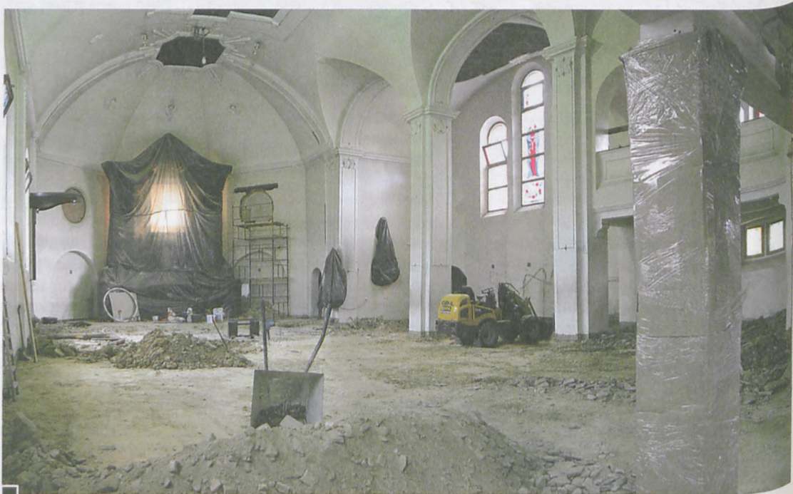
■ Wnętrze świątyni w dniu 17 kwietnia. Trwają prace przy usuwaniu gruzu z warstwy podkładu posadzki. Użyto do tego minimaszyn budowlanych (patrz: między filarami, po prawej). Warto zwrócić uwagę na, odtworzone w ścianie prezbiterium, okragłe otwory okienne przygotowane pod historyczne witraże, pochodzące z czasów, gdy świątynia należała do ewangelików fot. Hanna Siatka
