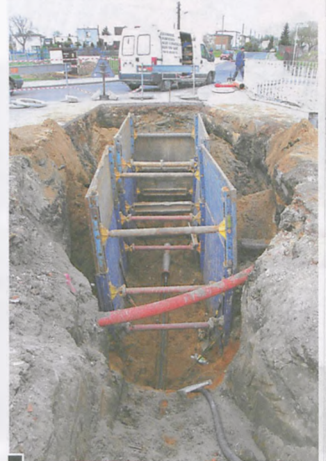
Przecisk na głębokości ponad 4 m z podłączeniem rury fi 250 do istniejącej kanalizacji sanitarnej przy mostku Strumienia Junikowskiego w ul. 3 Maja fot. Piotr P. Ruszkowski
