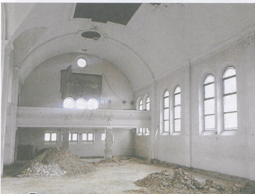
■ Rzadki widok zupełnie pustego kościoła – zdemontowano organy do konserwacji; u dołu widać prace przygotowawcze do montażu nowej posadzki fot. Rafał Wojtyniak
