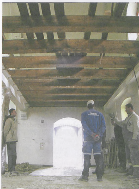
■ Po zdjęciu podłogi z balkonu chóralnego, pozostały jedynie belki stropowe fot. Hanna Siatka
