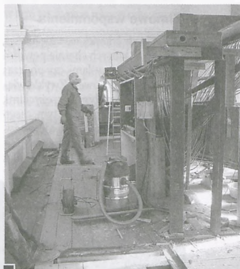
Fachowcy starannie rozbierają stare organy, by poddać je konserwacji i złożyć na nowo fot. Hanna Siatka
