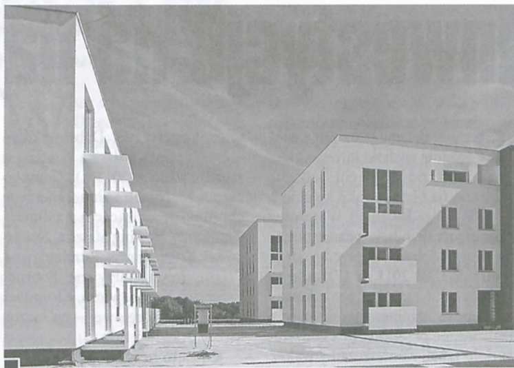
Budowa największego osiedla mieszkaniowego w Luboniu Warta-Park na terenie byłych Zakładów Ziemniaczanych fot. Katarzyna Polerowicz-Kelma
