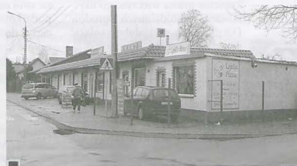
Dobudowany do ciągu sklepów narożnikowy pawilon pizzerii (według właściciela – wiaty), wykończony podobnie, jak pozostałe. Jedyna różnica dotyczy dachu – fot. Piotr P. Ruszkowski
