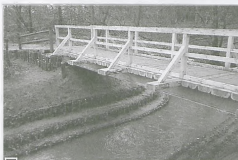
Mostek przez Wirynkę (8,2 km od lubońskiego stadionu), zabrany wcześniej przez powódź, tym razem posadowiono na stalowych tragarzach. Wyprofilowano i umocniono też i brzegi Wirynki fot. Paweł Jankowiak
