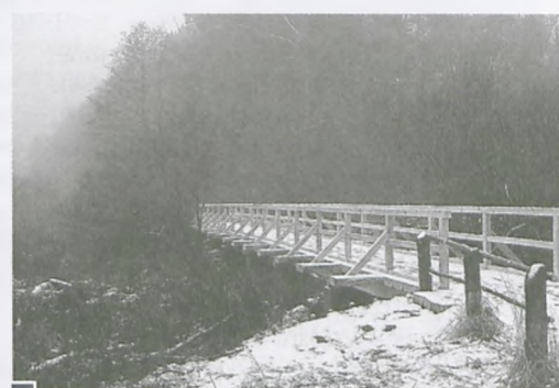
Odremontowany mostek Krzyśko na Kątniku, 6,8 km od stadionu przy ul. Rzecznej w Luboniu fot. Paweł Jankowiak
