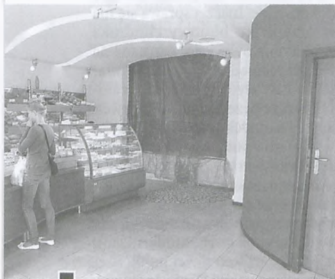
W sklepie TOSMAK przy ul. Osiedlowej – w dzień handel, wieczorami remont fot. Władysław Szczepaniak
