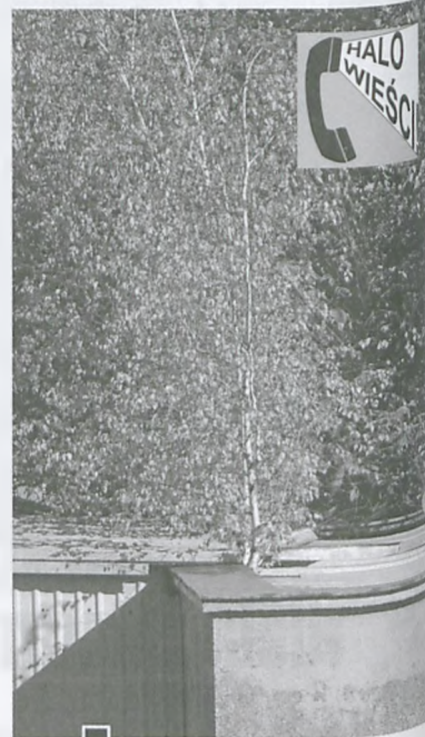
Wyrastające spod opierzenia dachu kilkumetrowe brzozy fot. Piotr P. Ruszkowski
