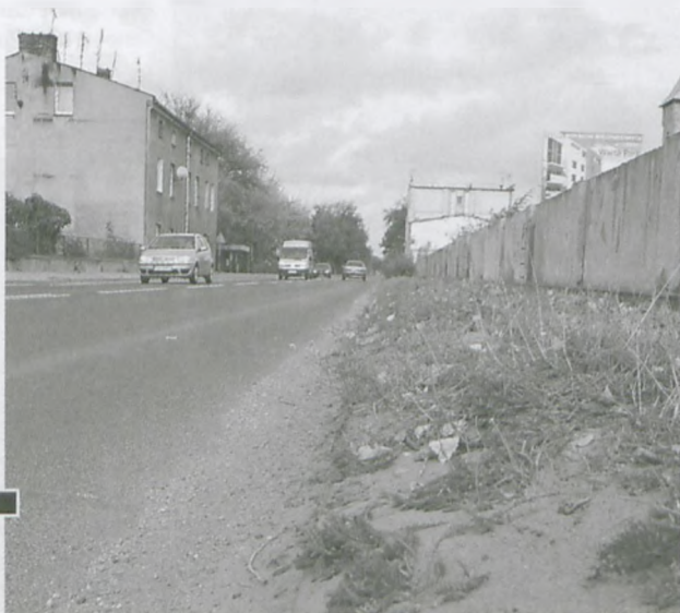
Przysypane piaskiem krawężniki ul. Armii Poznań fot. Piotr Paweł Ruszkowski
