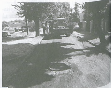
Zdzieranie wadliwie położonego asfaltu fot. Hanna Siatka
