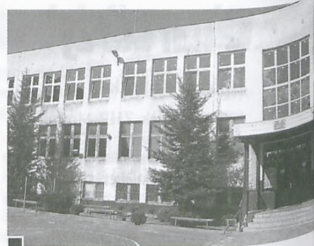
29 sierpnia rozpoczęto w SP3 wymianę starej, drewnianej stolarki okiennej na plastikową. Na zdjęciu wymienione okna na piętrze fot. Paweł Wolniewicz
