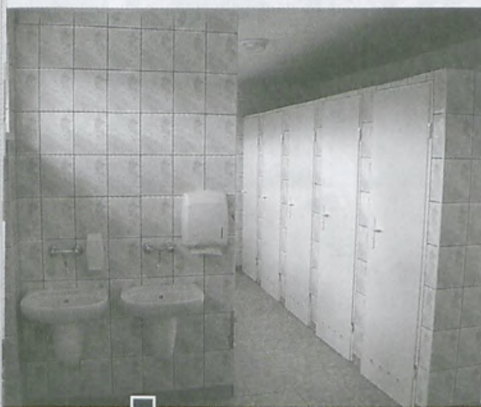
W ramach generalnego remontu toalety dla chłopców w SP 4 m.in. położono nową glazurę na ścianach i podłodze oraz zamontowano nowe urządzenia sanitarne fot. Paweł Wolniewicz
