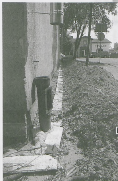
Odkopano, zaizolowano przed wilgocią i ocieplono styropianem fundamenty budynku Biblioteki Miejskiej przy ul. Żabikowskiej 42 fot. Piotr Paweł Ruszkowski
