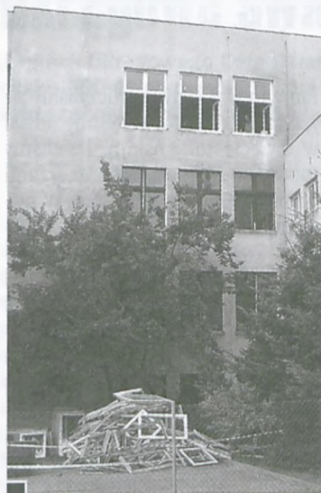
W Gimnazjum nr 1 trwają prace termomodernizacyjne analogicznie jak w Szkole Podstawowej nr 3 fot. Paweł Wolniewicz
