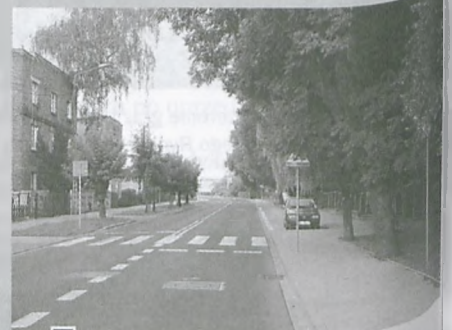
Widok z perspektywy kierowcy – zupełnie przysłonięte dwa znaki drogowe na ul. Fabrycznej. Widoczne są tylko słupki fot. Piotr Paweł Ruszkowski
