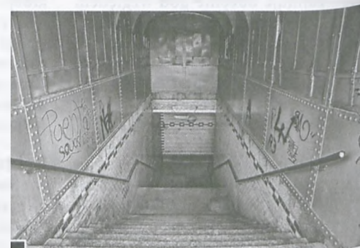
Cuchnący i zapomniany podczas remontu tunel łączący perony fot. Katarzyna Polerowicz-Kelma
