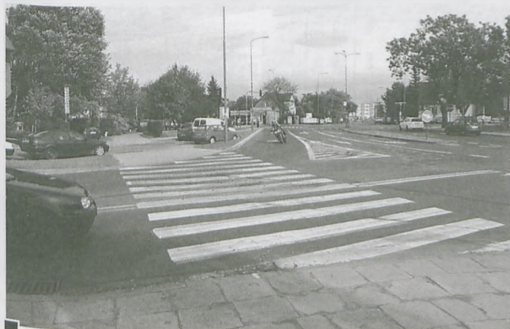
Widok przejścia przez ul. Kościuszki pozbawionego znaków pionowych, przy niewrażliwym i ruchliwym skrzyżowaniu fot. Hanna Siatka
