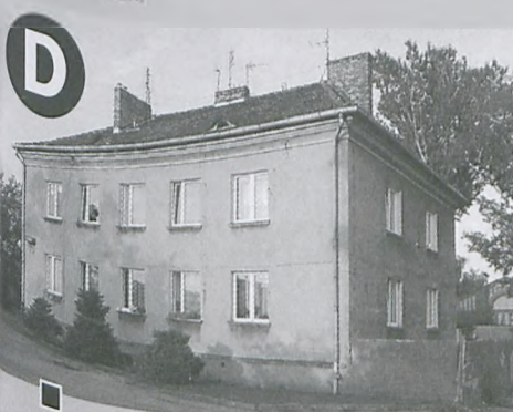
D Budynek mieszkalny przy ul. Armii Poznań 47A należący do spółdzielni Spółnia (na mapce oznaczony literą „D”) kolidować będzie z ciągiem pieszo-jezdnym fot. Piotr P. Ruskowski
