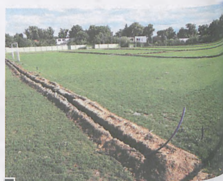
Murawa boiska Stelli poprzecinana rowami, w których układana jest instalacja wodna fot. Hanna Siatka
