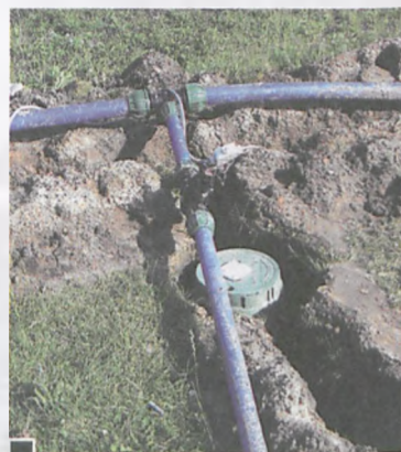
Jeden z automatycznie sterowanych zaworów rozprowadzających, zabezpieczony osłoną fot. Hanna Siatka
