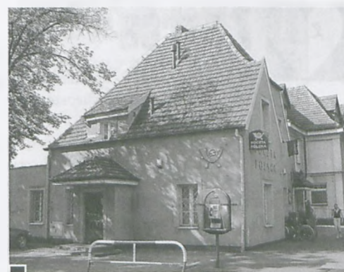
Zabytkowy budynek Urzędu Pocztowego w Żabikowie fot. Jan Błaszczak
