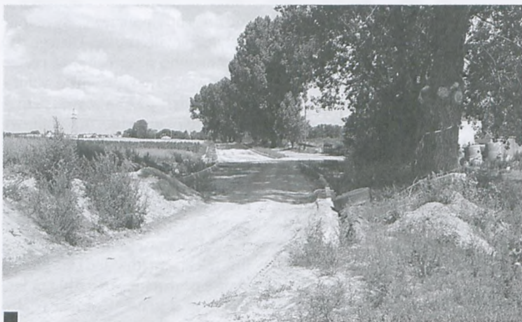
W tym samym miejscu przed miesiącem kończyły się ślady budowy lubońskiej obwodnicy fot. Piotr P. Ruskowski
