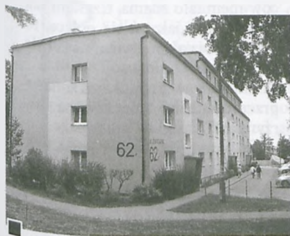
Blok F przy ul. Żabikowskiej 62, przed którym, doszło do napadu fot. Paweł Wolniewicz
