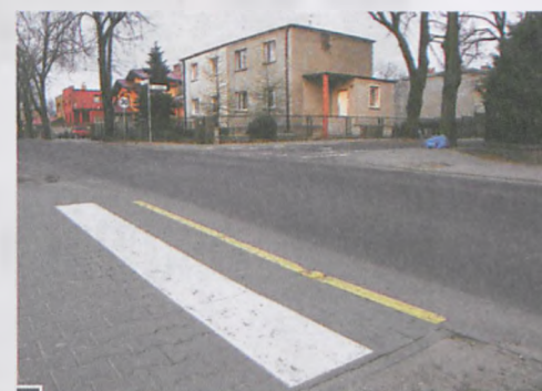
Europejski standard – biały, wypukły, szeroki pas dla niewidomych i cieńszy, żółty – ostrzegawczy – na chodniku ul. Poniatowskiego przy skrzyżowaniu z Lipową. Podobnie oznaczono również chodnik na ul. Lipowej na wysokości Centrum Medycznego HCP fot. Hanna Siatka
