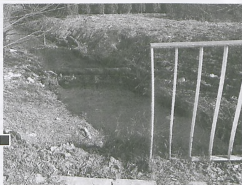
Niedostatecznie zabezpieczone strome zbocze Strumienia tuż przy chodniku fot. Paweł Wolniewicz
