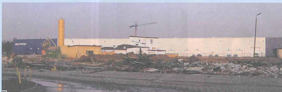
■ Wyburzone budynki odsłoniły widok na pierwszą halę Parku Przemysłowego postawioną przed kilkoma laty fot. Katarzyna Frąckowiak
