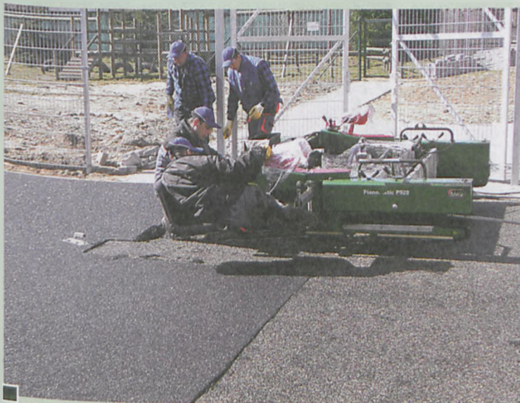
Układanie ostatniej warstwy nawierzchni sztucznego boiska fot. Piotr Paweł Ruszkowski
