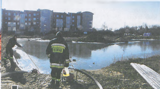
Wypompowywanie wody z wykopu przy ul. Wschodniej przez strażaków podczas odwilży 14 lutego. Według relacji strażaków, pracujące przez trzy dni po 7 godzin dwie pompy o wydajności 1200 litrów/min. przerzuciły do kanalizacji deszczowej ponad 3 000 kubików. Pozostała w wykopie woda miała wówczas głębokość około 60 cm fot. Hanna Siatka
