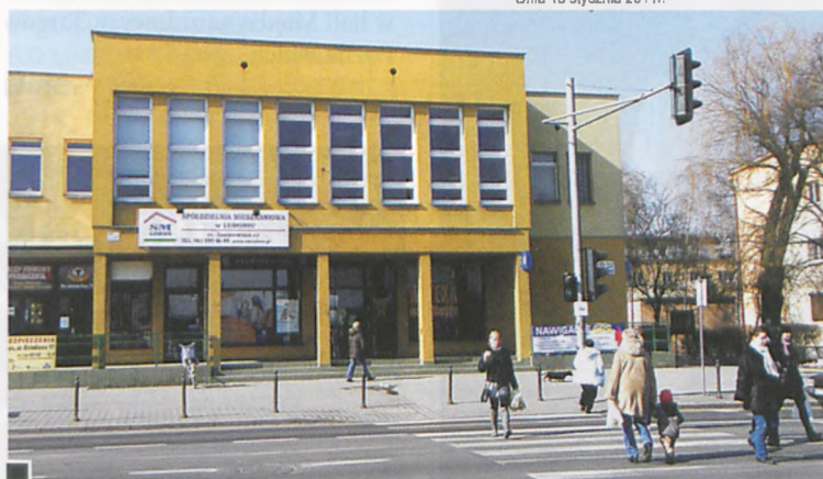
Siedziba Spółdzielni Mieszkaniowej w Luboniu przy ul. Żabikowskiej 62 fot. Izabela Aktas
