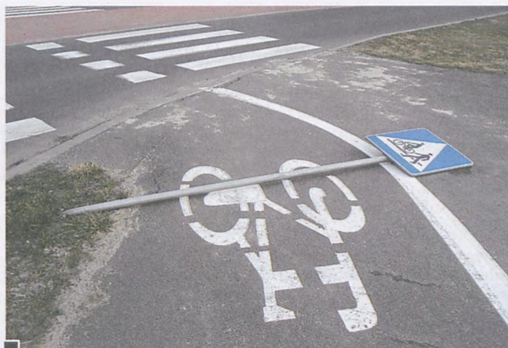
Przykład złamanego znaku na skrzyżowaniu z ul. Unijnej w ul. Łącznik fot. Jan Błaszczak
