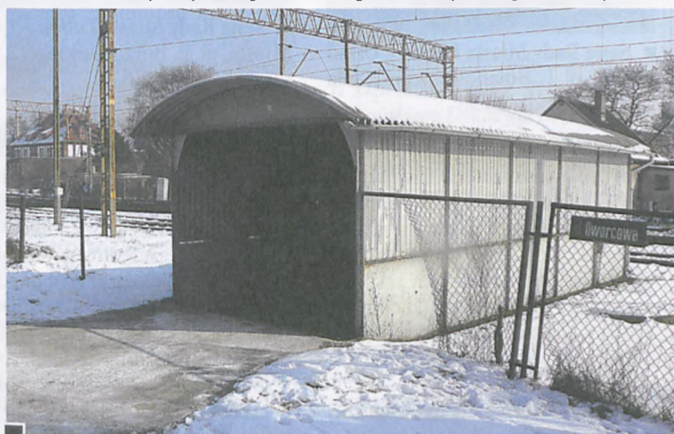
Podziemny tunel (widok od strony ul. Dworcowej, na wysokości ul. Fabrycznej), nie nadaje się do przejścia. Jedynym wyjściem dla pieszych się np. na autobus jest pokonanie torów nawet przy opuszczonym szlabanie fot. Paweł Wolniewicz
