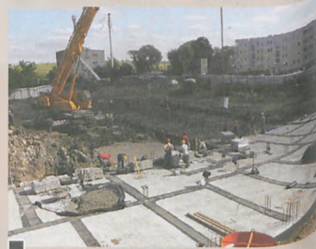
Na dziesięciocentymetrowym podbetonie położono płytę fundamentową żelbetową o grubości 60 cm (zużyto ponad 1000 m 3 betonu). fot. Paweł Wolniewicz
