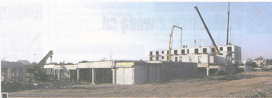
Na panoramicznym zdjęciu zrobionym z wysokości ujścia Strumienia Junikowskiego do Warty widać zaawansowanie prac na kolejnych czterech budynkach fot. Piotr P. Ruszkowski
