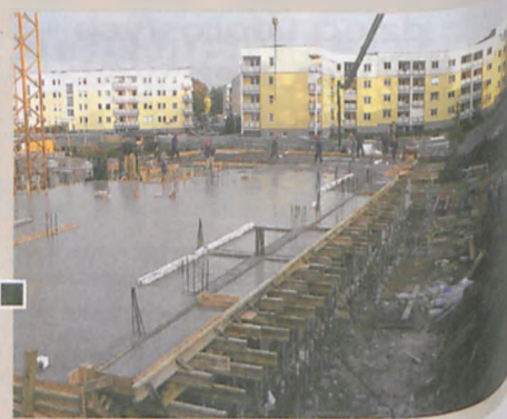
Na dziesięciocentymetrowym podbetonie położono płytę fundamentową żelbetową o grubości 60 cm (zużyto ponad 1000 m 3 betonu). fot. Paweł Wolniewicz
