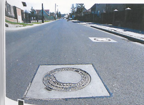
Płaskie wykończenie studzienek kanalizacyjnych na nowej nawierzchni ul. Cmentarnej fot. Hanna Siatka
