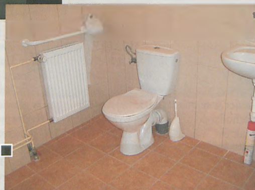
Specjalna toaleta dla niepełnosprawnych fot. Katarzyna Frąckowiak
