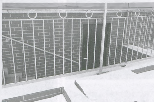
Wejście do pomieszczeń noclegowni położonych w suterenie znajduje się na tyłach budynku MOPS fot. Paweł Jankowiak
