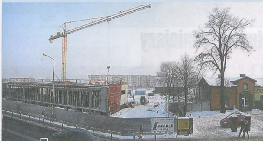
Pod koniec października w tym miejscu stał jeszcze stary chlew, dziś gotowa jest konstrukcja pierwszej kondygnacji i pomimo zimy za blaszanym, wysokim płotem trwają prace fot. Piotr P. Ruskowski
