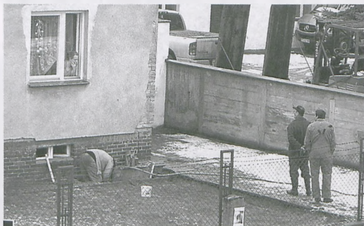
Wypompowywanie wody z piwnicy przy ul. Fabrycznej
