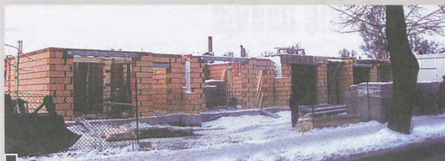
Szeregowiec mieszkalny przy ul. Kołłątaja w budowie fot. Hanna Siatka
