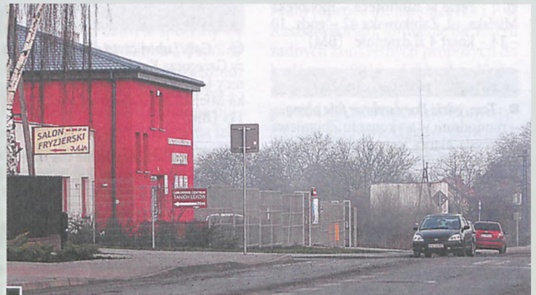
Niebezpieczne miejsce parkingowe na ul. Fabrycznej, o którym sygnalizowaliśmy w październiku 2009 r. na str. 11 fot. Łukasz Stachowiak
