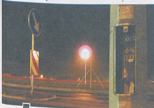
Ślady manipulacji przy lampie ulicznej (brak bezpieczników) w celu zaciemnienia miejsca przestępstwa fot. Rafał Wojtyniak
