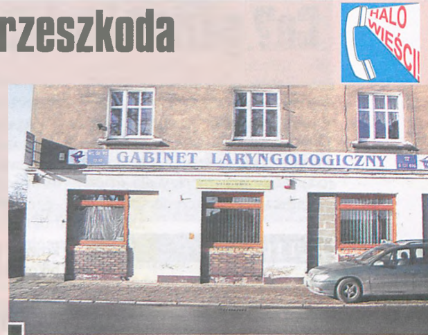
Fatalny chodnik na ul. Dworcowej fot. Małgorzata Marx
