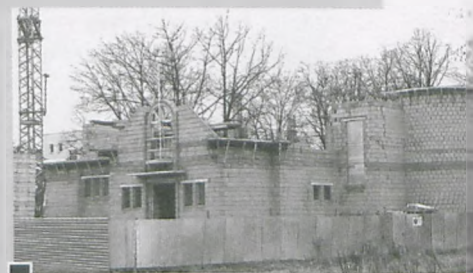
Stan zaawansowania prac przy budowie nowej świątyni przy ul. Źródlanej fot. Hanna Siatka
