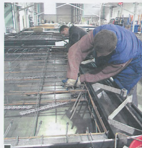
Zanim ściana zostanie wypełniona specjalnym betonem, montuje się wiele elementów stanowiących o jej wytrzymałości ze względu na różne parametry, systemy montażu, chwytów transportu itd. fot. Piotr P. Ruszkowski
