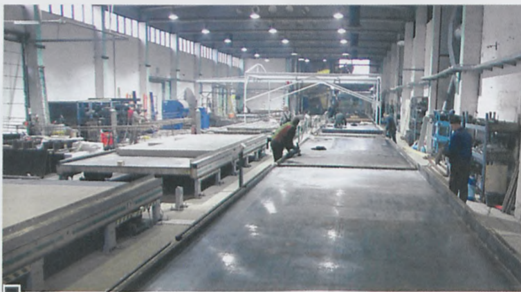
Wnętrze hali produkcyjnej. Na wielkich, gładkich, stalowych płytach montuje się szalunki, zbrojenia i wylewa ściany domów fot. Piotr P. Ruszkowski
