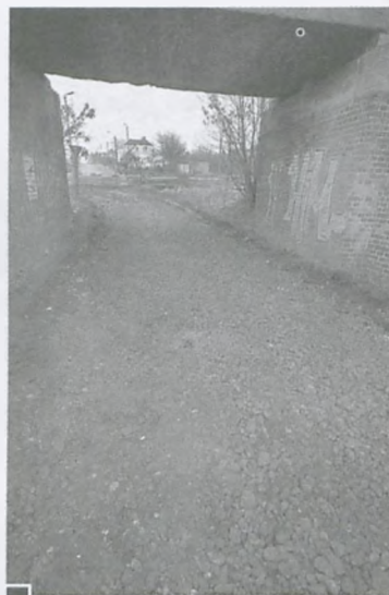
Widok obecny – wyrównane i i utwardzone przejście pod tunelem fot. Paweł Jankowiak
