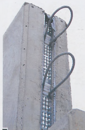
Specjalny system „Pfeifer” bezpiecznego i precyzyjnego montażu gotowych ścian. Pomiedzy stalowe pętle zmontowanych sąsiednich elementów wstawia się pręty zbrojeniowe i zalewa betonem fot. Piotr P. Ruszkowski
