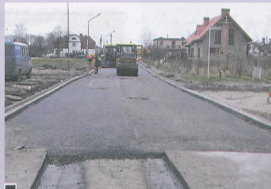
Asfaltowanie ul. Targowej fot. Piotr P. Ruszkowski
