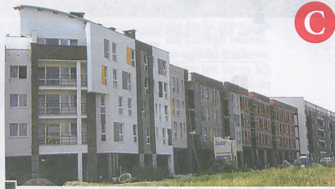
W 1/3 części gotowa, w pozostałych – w budowie – pierzeja Budoformy i Romosu przy deptaku – ul. Andrzeja Mizerki fot. Hanna Siatka
