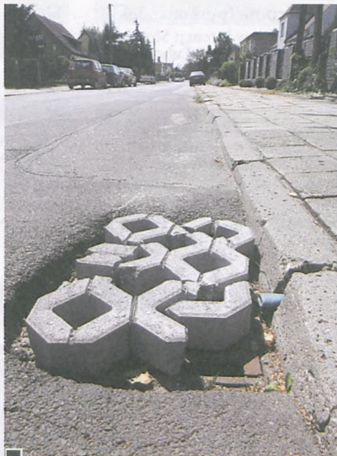
Ażurowy beton zabezpiecza „zapadnięty” gulik fot. Piotr P. Ruszkowski
