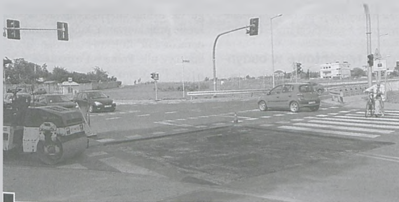
Roboty przy kładzeniu fragmentu nowej nawierzchni asfaltowej fot. Hanna Siatka
