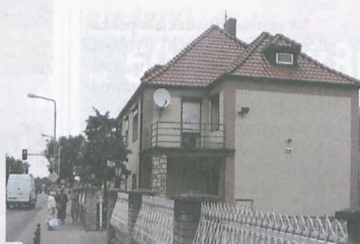
Największy i najokazalszy z budynków przeznaczonych do wyburzenia – dom ogrodniczej rodziny – Szafranów, dalej również słynna cukiernia Krzyżan oraz inne pawilony w tej linii fot. Paweł Wolniewicz
