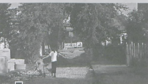
Remont ul. Cmentarnej rozpoczęto od strony ul. Poniatowskiego fot. Piotr Grzybała
