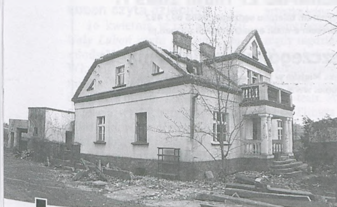
Pozostałości dworku wzniesionego w latach 30. XX wieku na miejscu wcześniejszych siedzib. Na zdjęciu, rozebrany już charakterystyczny dla polskiej architektury naczółkowy dach. Wdzięku budowlę dodawał ganek wsparty na dwóch parach kolumn dźwigających taras pierwszego piętra, nad którym widoczna jest wystawka z niszą na figurę Serca Jezusowego i rokiem postawienia domu (1933)
