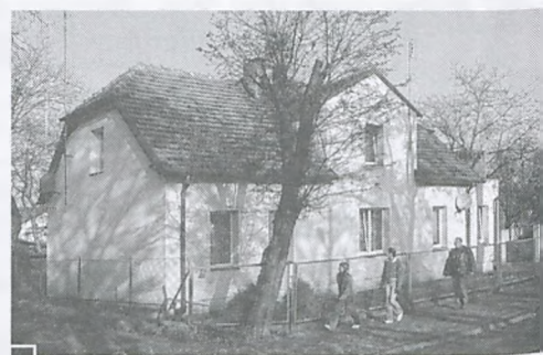
Budynek dawnej Stacji Opieki nad Matką i Dzieckiem przy ul. Poniatowskiego 13 – wygląd obecny fot. Mateusz Pokrywka
