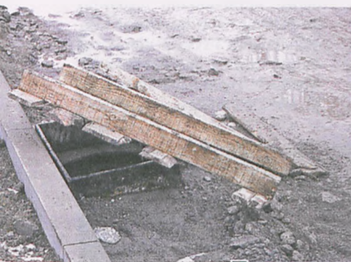
Przykłady niezabezpieczonych studzienek, które stanowią zagrożenie fot. Paweł Jankowiak
