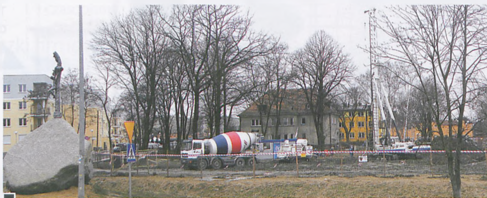
Na pustym dotąd placu parafialnym przy ul. Źródlanej ruszyły intensywne prace budowlane fot. Hanna Siatka
