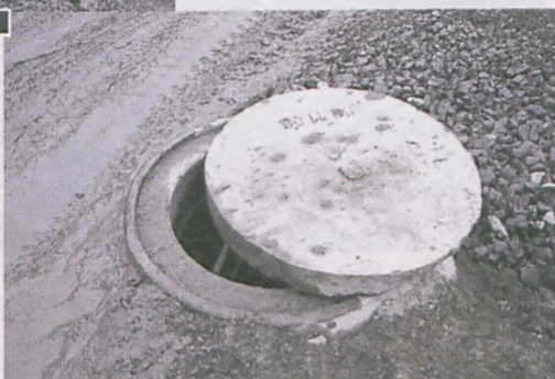
Przykłady niezabezpieczonych studzienek, które stanowią zagrożenie fot. Paweł Jankowiak
