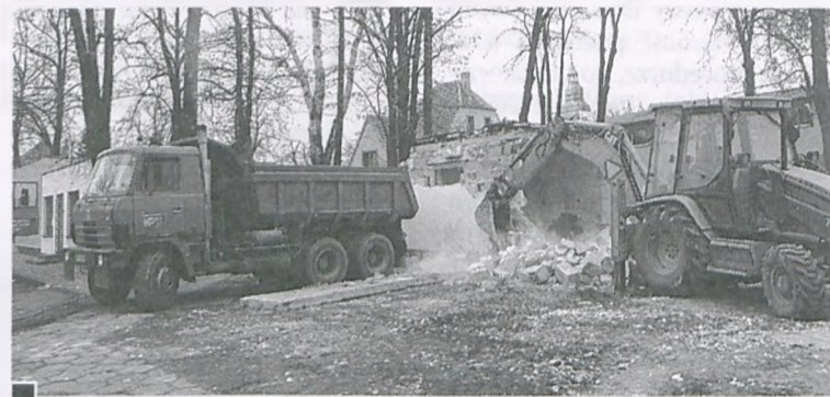
29 stycznia – wyburzanie nieczynnego od kilku lat sklepu spożywczego „Ptyś”. Po sąsiednim zakładzie fotograficznym parństwa Krukowskich nie zostało już nic fot. Hanna Siatka
