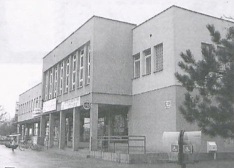
Budynek administracji Spółdzielni Mieszkaniowej Lubonianka przy ul. Żabikowskiej 62 fot. Piotr P. Ruszkowski
