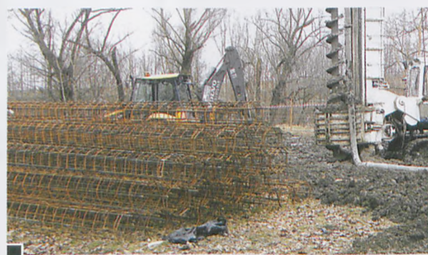
Dziewięciometrowe zbrojenia przygotowane do palowania fot. Hanna Siatka
