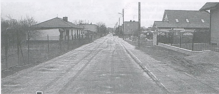
Na ul. Jana Panka najprawdopodobniej jeszcze w tym roku rozpocznie się budowa kanalizacji sanitarnej fot. Magdalena Woźniak-Patej
