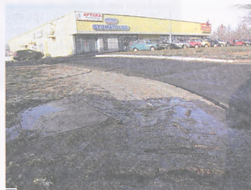
Wydostająca się spod klapy studzienki telekomunikacyjnej woda fot. Piotr P. Ruszkowski
