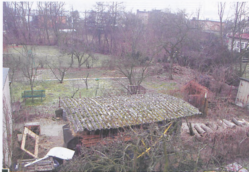
Widok na kruszący się dach azbestowej wiaty przy ul. Hibnera
