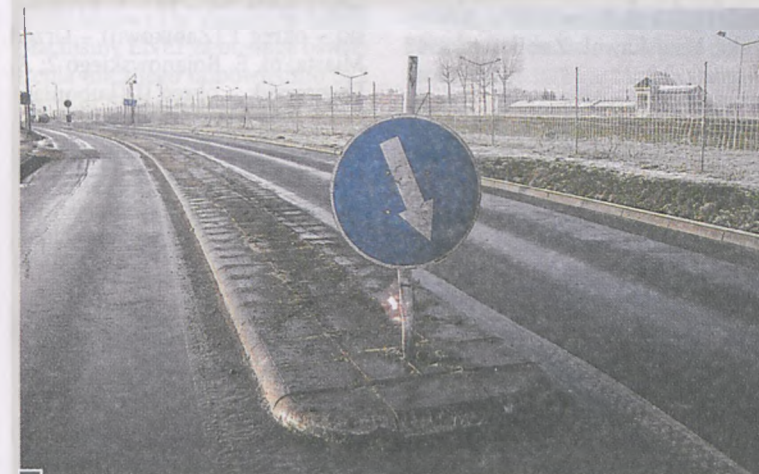
Wciąż niszczone nieoświetlony znak na ciemnym odcinku ul. Unijnej fot. Jan Błaszczak
