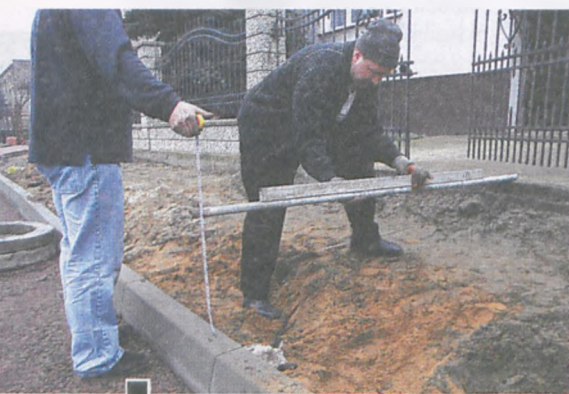
Różnica poziomów (45 cm) krawężnika i posesji. Z takim nachyleniem układany jest chodnik fot. Piotr P. Ruszkowski
