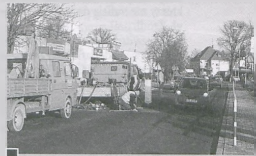
Ulica Żabikowska, na zdjęciu podczas robót, jest już gotowa fot. Mateusz Pokrywka
