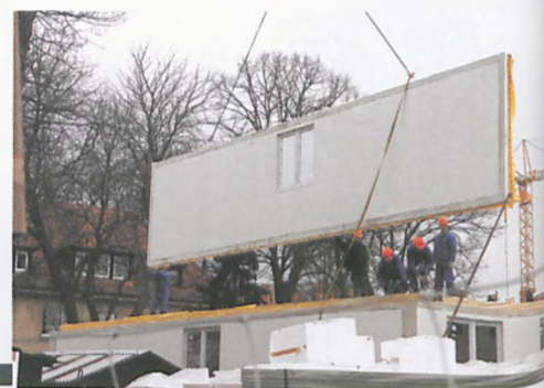
Montaż zewnętrznej ściany pierwszego piętra budynku z wprawionym już oknem, ociepleniem i tynkiem fot. Paweł Jankowiak
