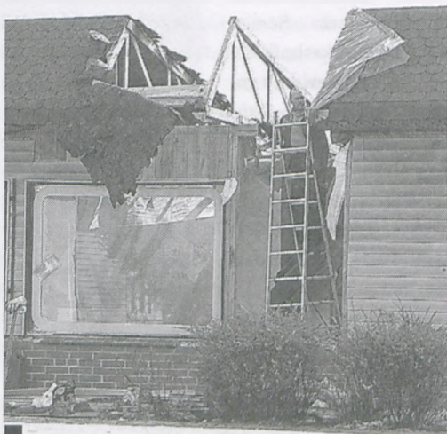
Każdy opuszczony pawilon likwidowanego centrum handlowego przy narożniku ulic: Żabikowskiej i Paderewskiego jest natychmiast rozbierany fot. Paweł Jankowiak
