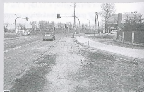
Prace przygotowawcze do poszerzenia jezdni ul. Poniatowskiego o prawoskręt w ulicę Kościuski. Wykonano już nowy chodnik fot. Paweł Jankowiak
