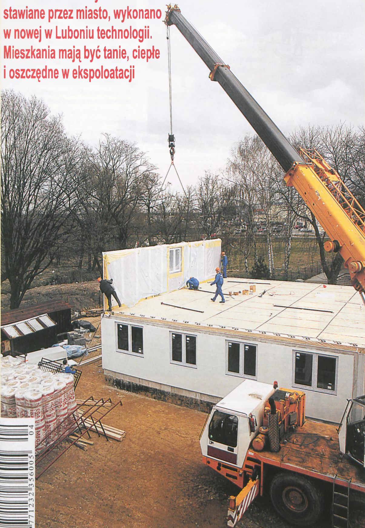
fol. Paweł Jankowiak / Budowa bloków komunalnych i socjalnych przy ul. Żródlanej
