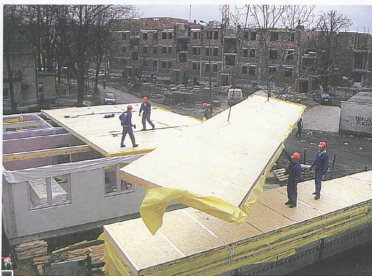
Moment montażu gotowych płyt stropowych ocieplonych wełną mineralną i zabezpieczonych folią. Widoczna jest lokalizacja drugiego budynku w sąsiedztwie MOPS-u (z lewej) i powstającego bloku Luboniani fot. Jan Błaszczak
