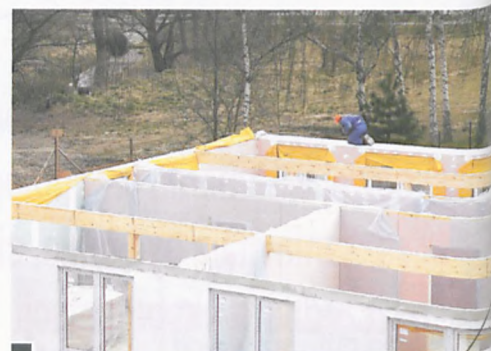
Główną konstrukcję budynku stanowią belki z klejonego drewna fot. Paweł Jankowiak
