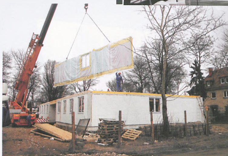
Montaż zewnętrznej ściany pierwszego piętra budynku z wprawionym już oknem, ociepleniem i tynkiem fot. Paweł Jankowiak
