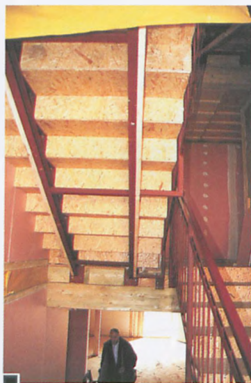
Metalowa konstrukcja klatki schodowej ze schodami wykonanymi z wiórowej płyty OSB odpornej na wilgoć i odkształcenia fot. Paweł Jankowiak
