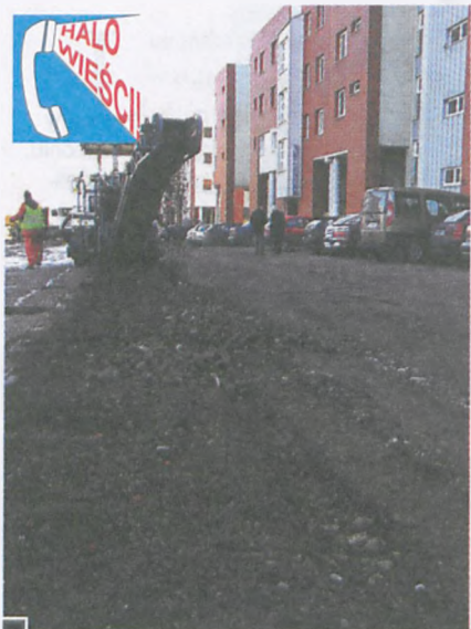
Zabieg frezowania na ul. Wschodniej ma być przeprowadzony także na alei Jana Pawła II. Koszt modernizacji ulicy gruntowej tą metodą wynosi ponad 7 zł za m 2 fot. Piotr P. Ruszkowski
