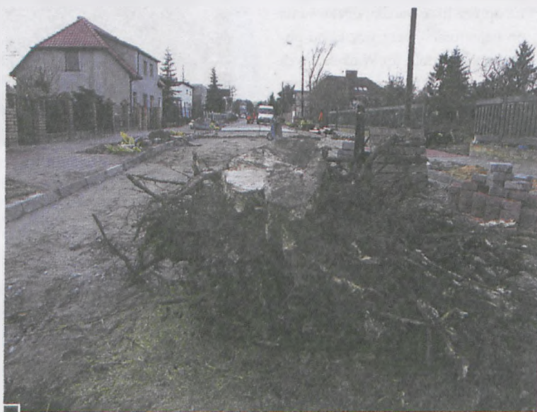
Korzenie zdrowych drzew usunięte z nieutwardzonej części ulicy (od strony ul. ks. Streicha) fot. Piotr P. Ruszkowski
