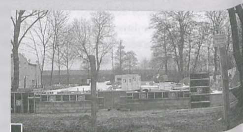
Fundamenty budynku komunalnego stawiane przy ul. Źródlanej fot. Jan Błaszczak
