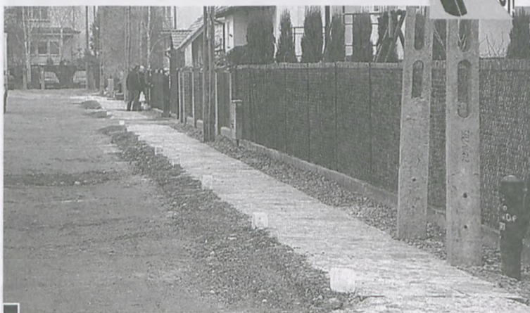
Tymczasowy chodnik na ul. Andersena – marzenie mieszkańców wielu ulic nieutwardzonych. Wartym powielenia jest zastosowanie pionierskiego w Luboniu rozwiązania – przeszkód dla aut w postaci słupków fot. Paweł Jankowiak
