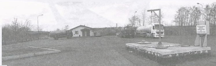
Widok zlewni od ul. Dębieckiej. Z lewej ślad po przeniesionych w głąb terenu stacjach odbiorczych. Z prawej – nieczynna przepompownia z 2003 r. W głębi budynek pracownika zlewni i dwa stanowiska odbioru fot. Hanna Siatka
