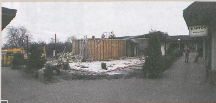
Rozbiórka pierwszych pawilonów w Gesie fot. Piotr P. Ruszkowski
