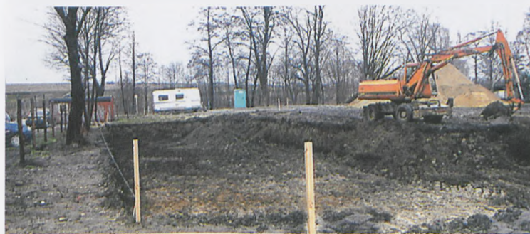
Rozpoczęto wykopy pod fundamenty domu komunalnego przy ul. Źródlanej fot. Jan Błaszczak
