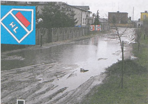
Ul. Warzywna podtopiona od płotu do płotu. Przejedźność – tragedia, przejść można tylko prawą stroną między drzewkami, które posadziili mieszkańcy. Co się dzieje z pieniędzmi na remonty dróg w Luboniu, a w szczególności w Lasku? fot. Tomasz Michalski
