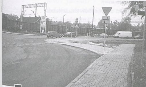
Nowy, poprawiony, prostopadły wlot z ul. R. Maya w drogę wojewódzką ul. Armii Poznań. Szkoda, że nie dokończono chodnika – skrót do przystanku autobusowego fot. Katarzyna Frąckowiak
