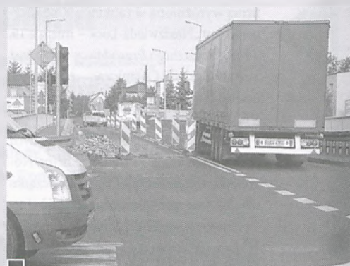
Uciążliwości komunikacyjne i prace na wiadukcie przy ul. Kościuszki fot. Hanna Siatka
