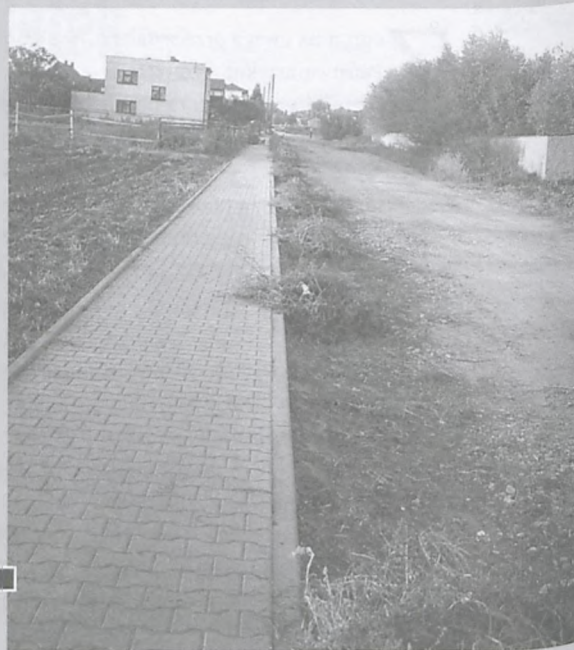
Kupki chwastów czekają na usunięcie fot. Katarzyna Frąckowiak
