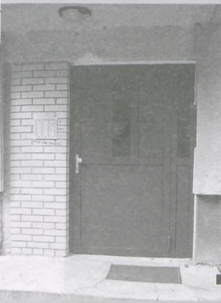
Przebudowane wejście fot. Paweł Jankowiak
