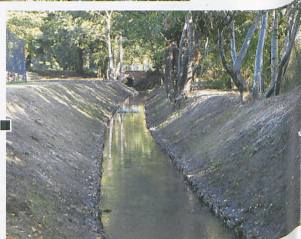
Potok po regulacji. Mostek na grobli młyna „Olszak”, którego historia sięga XIII w., będzie rozebrany i zastąpiony nowoczesnym z większą niż dotychczasowa 1,5 śrnicą przepustu fot. Piotr P. Ruszkowski
