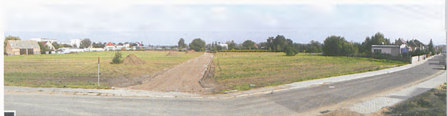
Powstała droga dojazdowa na placu budowy jako przedłużenie alei Jana Pawła II (nazwę ustanowiono 20 lipca bieżącego roku). Wielorodzinny blok Maxbudu stanie na polu po prawej jej stronie. fot. Piotr P. Ruszkowski
