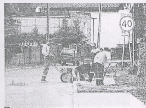
Budowa chodnika na ul. Kilińskiego fot. Paweł Jankowiak
