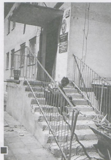
Podczas prac remontowych fot. Katarzyna Frąckowiak
