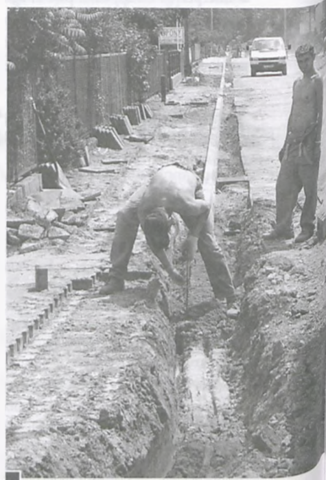
Po budowie kanalizacji sanitarnej w ul. ks. Stanisława Streicha przystąpiono do odtworzenia nawierzchni chodników i jezdni. Zaniepokojonych mieszkańców okolicznych posesji, za burmistrza Kędrę uspakajamy, że przyłącza wyprowadzone zostały z kolektora głównego poza chodnik w kierunku granic posesji. Obawy dotyczące ewentualnej rozbiórki nowego chodnika podczas podłączenia są więc, zdaniem Burmistrza, nieuzasadnione fot. Piotr P. Ruszkowski
