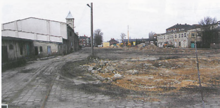
Równoległe do ul. Armii Poznań w pokazanym na zdjęciu miejscu (widok od str. ul. C. Ratajskiego) stanie trzeci duży blok mieszkalny (zdjęcie wykonane z punktu B – patrz mapka) fot. Piotr P. Ruszkowski
