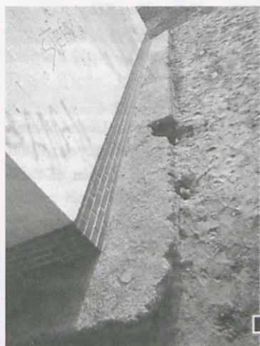
Pęknięcie ściany na całej wysokości fot. Piotr P. Ruszkowski
