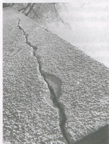
Pęknięcie ściany na całej wysokości fot. Piotr P. Ruszkowski
