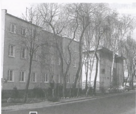
Na pierwszym planie – starszy budynek przy ul. Niepodległości, w głębi – nowy fot. Hanna Siatka
