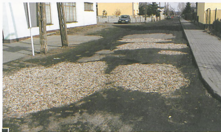
Jedynym, ale niestety rzadko stosowanym, sposobem na dziury w drogach nieutwardzonych jest uzupełnianie ich kruszywem budowlanym fot. Paweł Jankowiak
