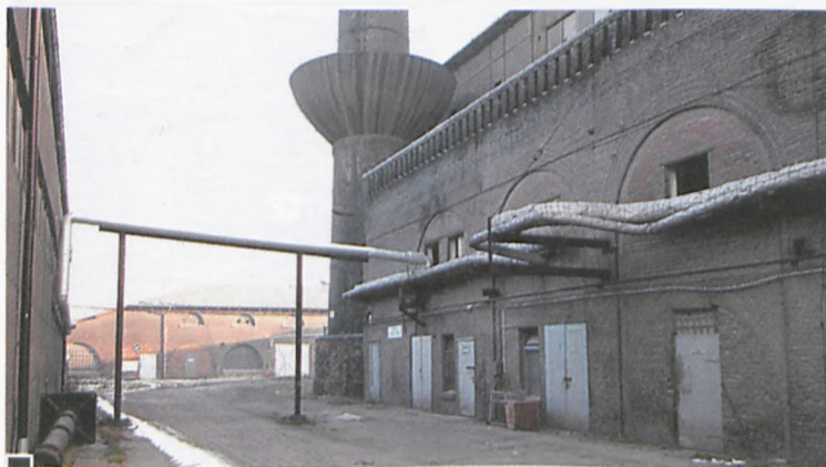
Z prawej maszynownia siłowni energetycznej oraz komin ze zbiornikiem wodnym typu Intze z 1911 r., w głębi warsztat mechaniczny z lat 1909-1914
