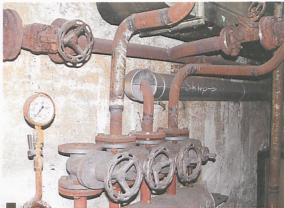
System nieczynnej instalacji grzewczej z kotłowni Zakładów Ziemniaczanych fot. Paweł Jankowiak
