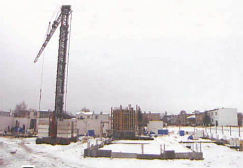
Plac budowy nowego bloku Buddom-Lomexu widziany z punktu B (mapa) fot. Piotr P. Ruszkowski
