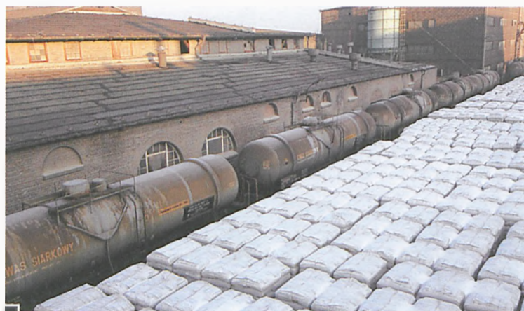
Magazyn półproduktów jest jedynym zachowanym fragmentem fabryki superfosfatu z lat 1909-1914, rozebranej w 1966 r. Z prawej, w głębi – oddział tlenku wanadu z 1974 r.
