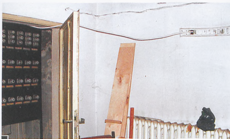
Prąd podłączany jest jedynie doraźnie za pomocą kabla. Nie korzysta się z istniejącej instalacji elektrycznej z obawy na jej stan. Prąd rozprowadzany jest po budynku przedłużaczami. fot. Paweł Jankowiak
