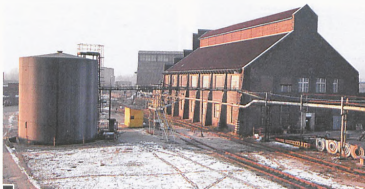
Piecownia wschodniej fabryki kwasu siarkowego z lat 1909-1914, w głębi magazyn pirytu z 1950 r.
