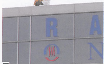
Oczyszczanie Centrum Handlowego PAJO fot. Paweł Jankowiak
