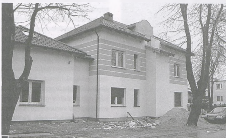
W budynku przy ul. Lipowej 60 tempo prac jest obecnie wolniejsze fot. Hanna Siatka
