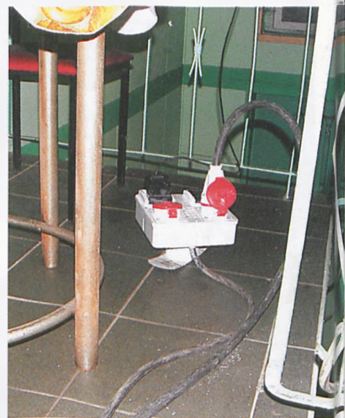
Prąd podłączany jest jedynie doraźnie za pomocą kabla. Nie korzysta się z istniejącej instalacji elektrycznej z obawy na jej stan. Prąd rozprowadzany jest po budynku przedłużaczami. fot. Paweł Jankowiak
