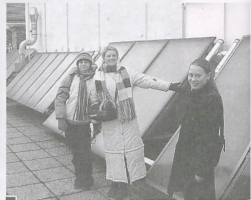
Przy bateriach słonecznych, na dachu szkoły w Wiedniu
