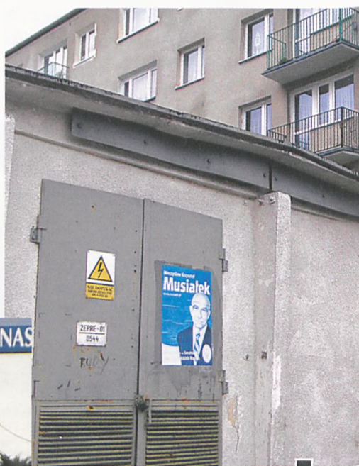
Plakaty wyborcze na trafostacji w Luboniance – ul. Osiedłowa fot. Piotr Paweł Ruszkowski
