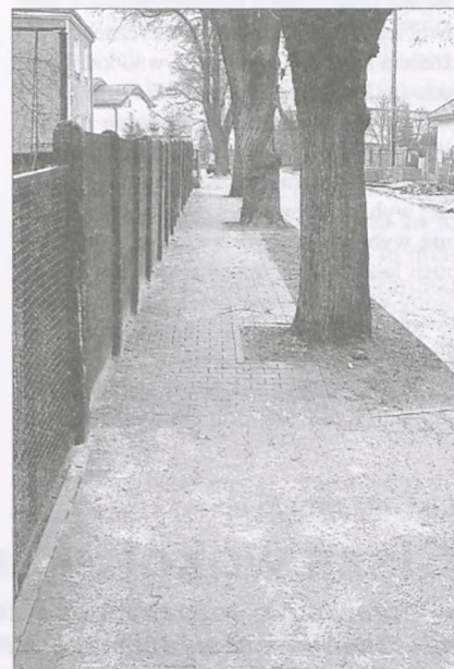
Nowy chodnik na ul. Lipowej
