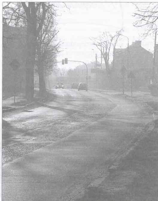
Zarząd Dróg Wojewódzkich w planach inwestycyjnych na 2005 r. już wcześniej przeznaczał ok. 2 mln zł na remont ul. Armii Poznań w Luboniu
