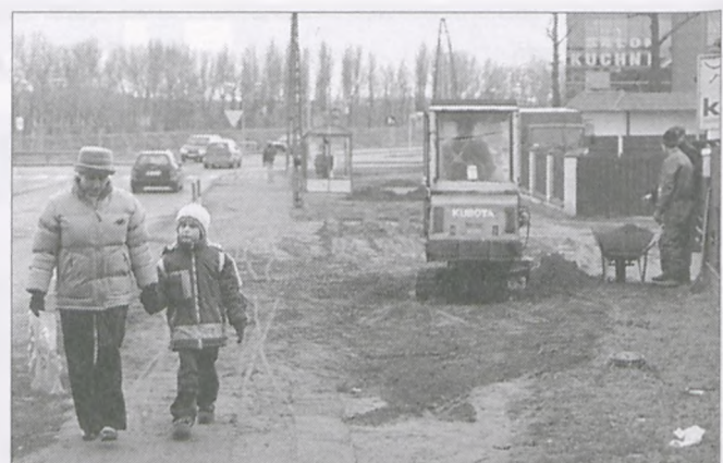
Rozpoczęto prace związane z I etapem przebudowy skrzyżowania ulic Kościuski, Poniatowskiego i Unijnej – ustawienie sygnalizacji świetlnej
