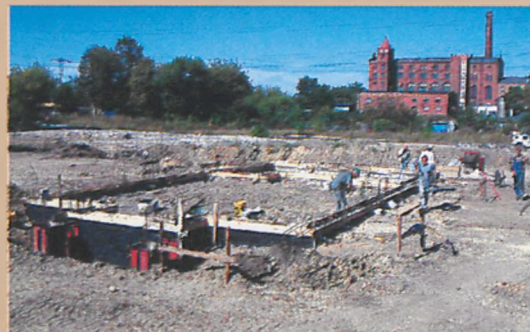
Fundamenty kaplicy z widokiem na drożdżownię
