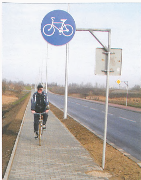
Wzdłuż nowej drogi – na całej długości – biega chodniki i ścieżka rowerowa. W kilku miejscach położone są obok siebie – po tej samej stronie drogi, gdzie indziej – po przeciwnych. Tam, gdzie trakty wykonano z kostki brukowej, chodnik jest czerwony, a droga dla rowerów – szara.
