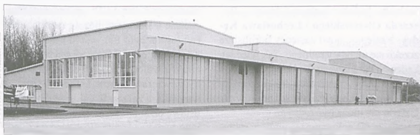
Hangar w standardzie NATO
