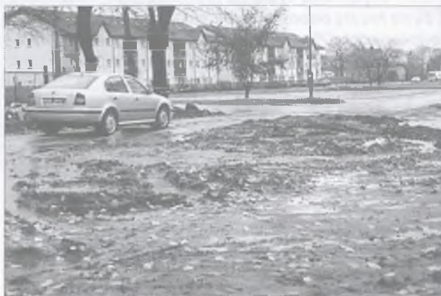
Skrzyżowanie ul. Buczka i Żabikowskiej – miejsce, w którym prowadzone były prace instalacyjne
