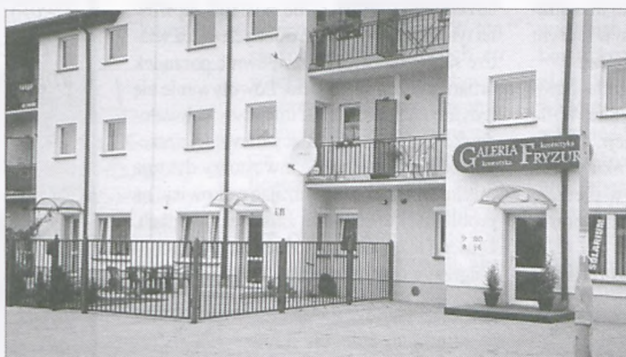
Przyziemie budynku przy ul. Sobieskiego 16 wybudowane jako lokal handlowy, zamienione na mieszkanie z „ogródkiem”
