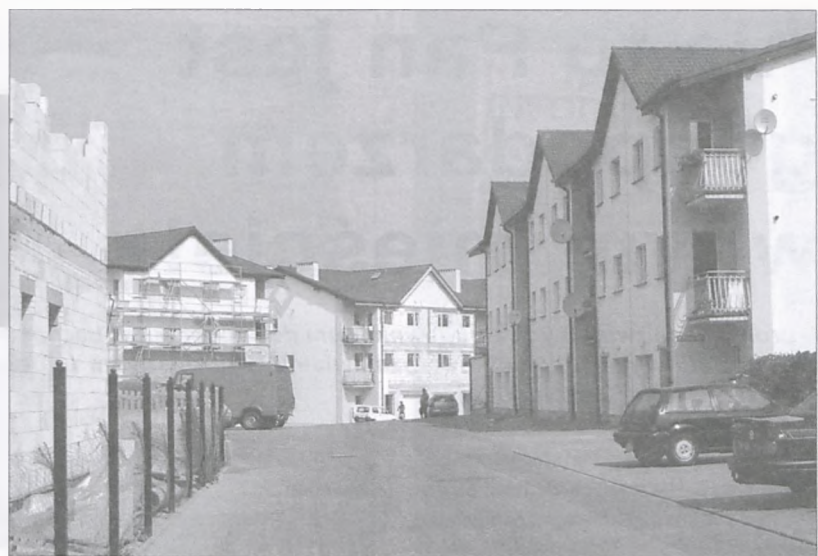
Budownictwo o charakterze jednorodzinnym przy ulicy 11 Listopada.
