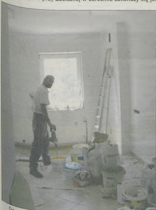
Remont budynku przy Zacisznej w Jarocinie zakończy się jesienią. Urządzonych ma w nim zostać 18 małych mieszkań
